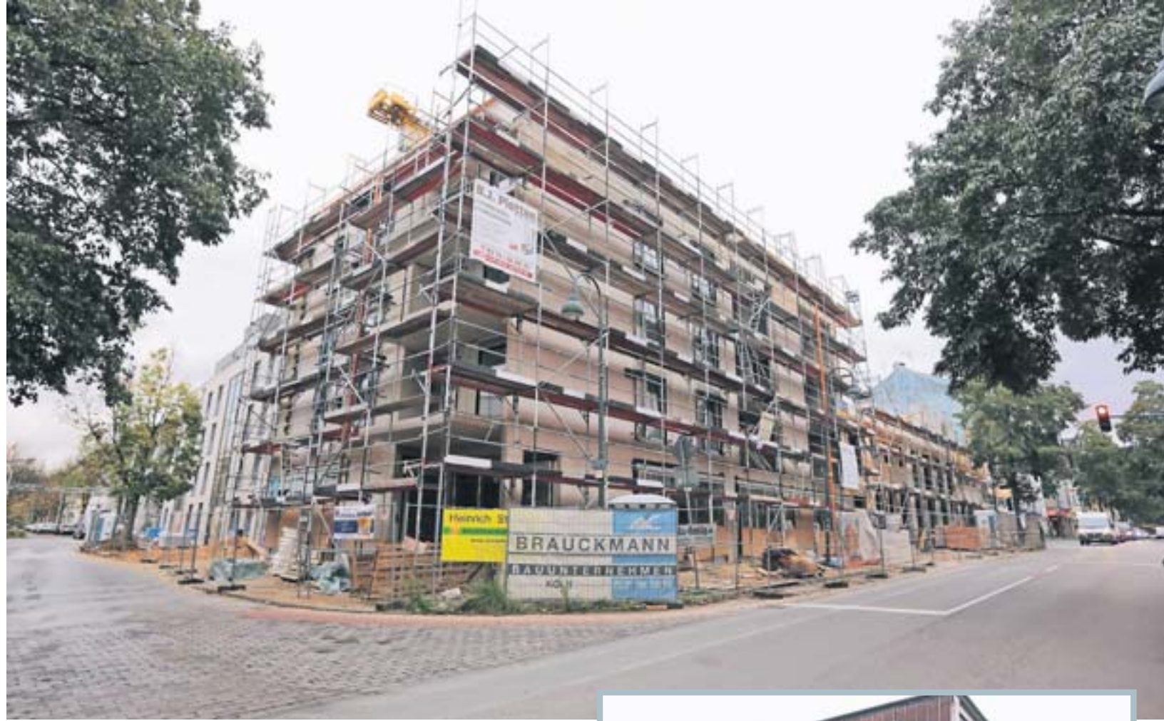
An der Kölner Straße 97-99 wird gebaut. Dort sollen 14 Wohnungen und eine Gewerbeeinheit entstehen. FOTO: UWE MISERIUS
