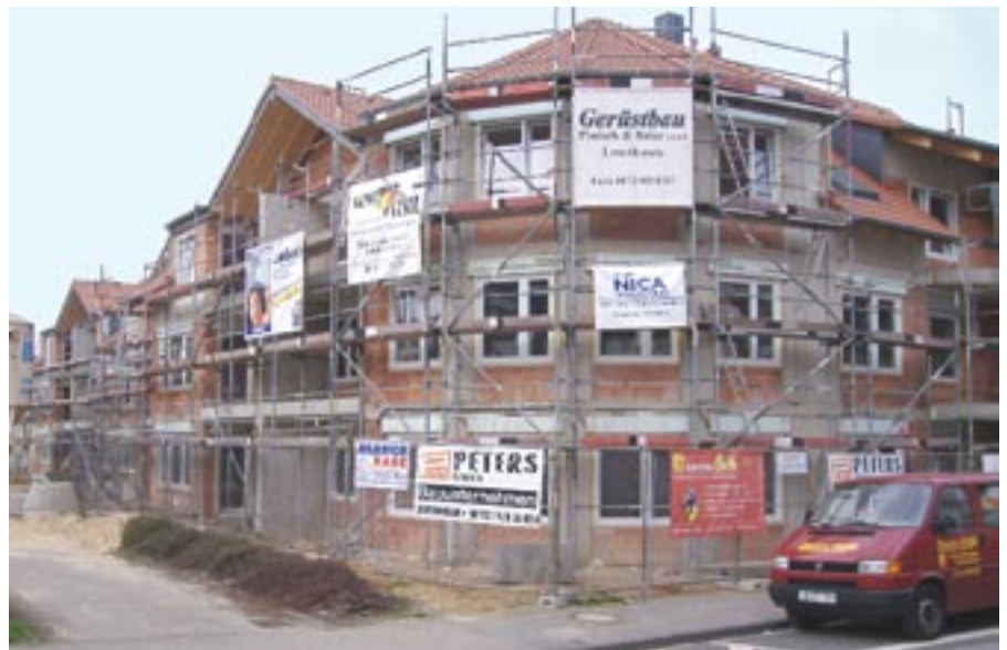
Planmäßig vorangeschritten: die Neubaumaßnahmen am „Alten Gaswerk“
