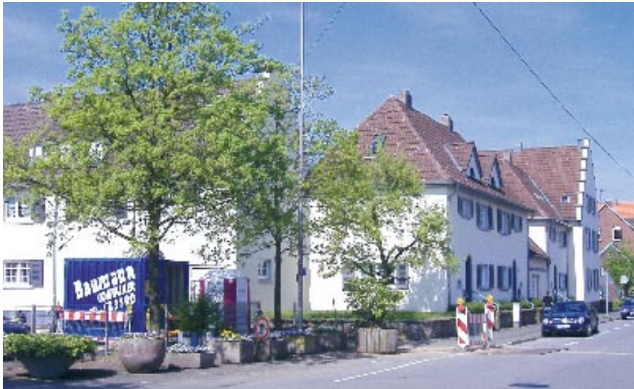
Abgeschlossen: die notwendigen Außensanierungsarbeiten der Feuerwehrsiedlung
