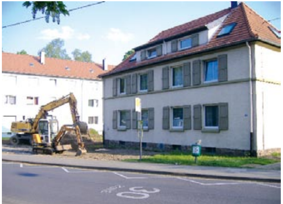
Baumaßnahmen des GBO an der Steinstraße...
