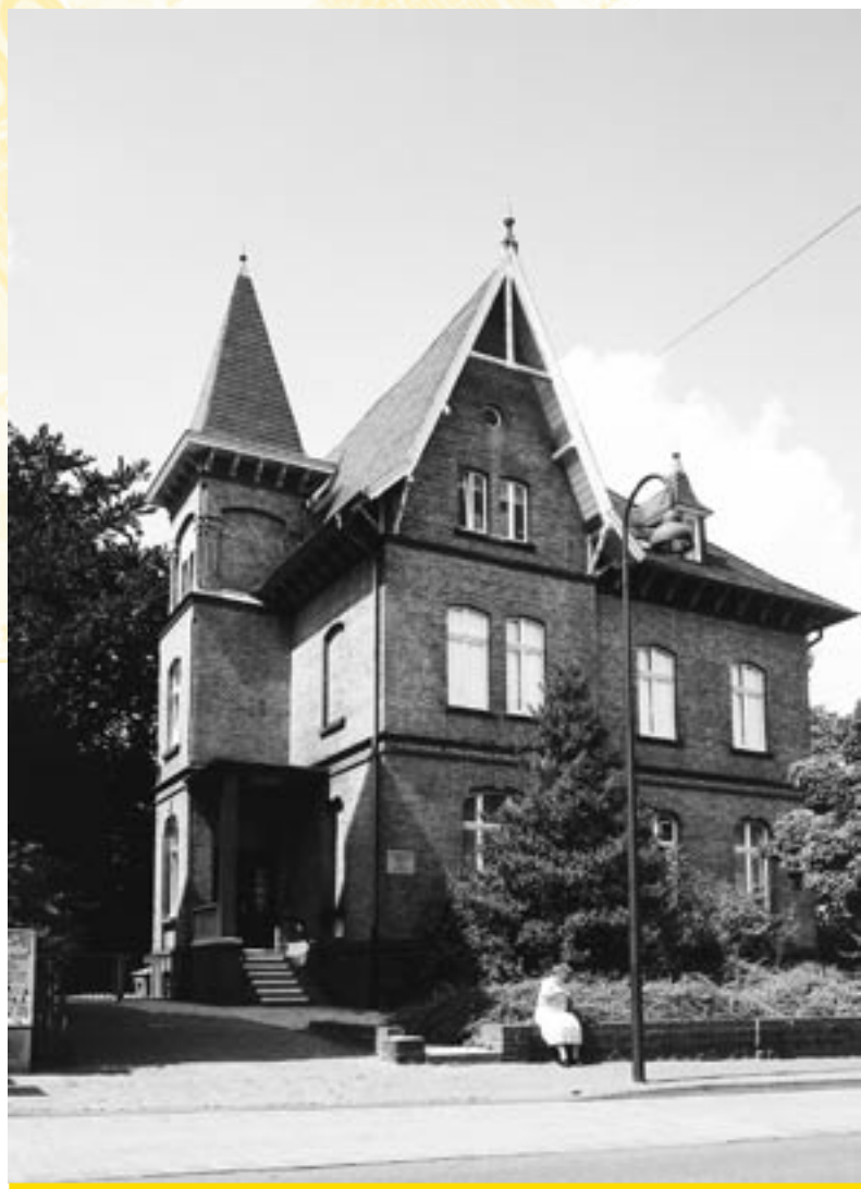
Begegnungsstätte in der Kölner Straße 100
