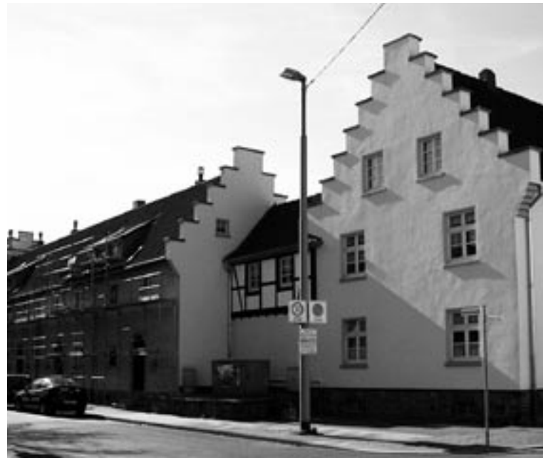
Sanierungen in der Birkenbergstraße
