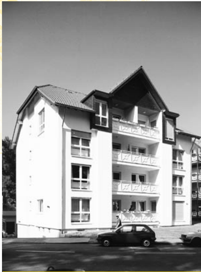
Neubau in der Reuschenberger Straße 52 a
