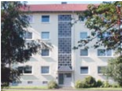
Umfangreiche Sanierungsarbeiten an der Breslauer Straße 17...
