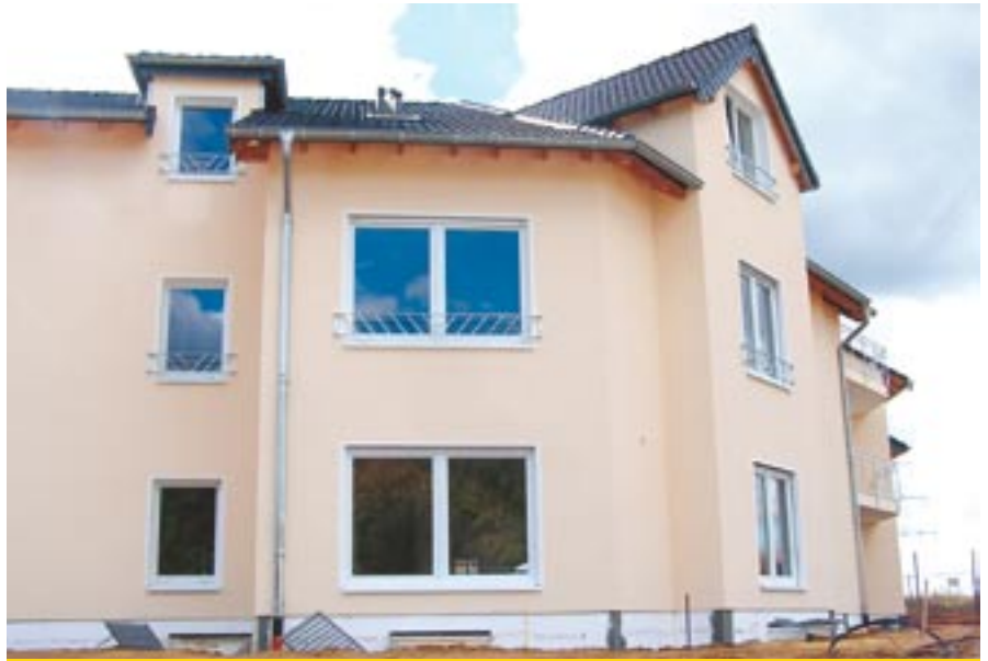
Das ging schnell: Der Neubau an der Sandstraße steht kurz vor der Fertigstellung.
